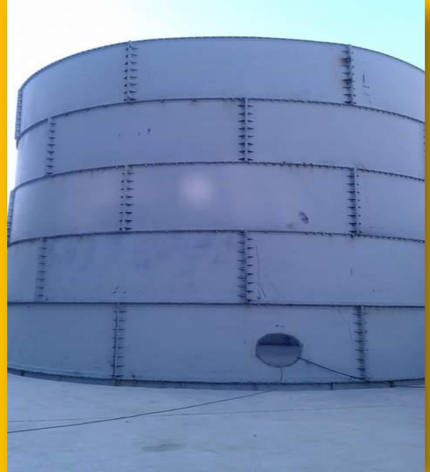
إنشاء تنك هواء بمترو الانفاق بالقاهرة ٢٠٢٠
